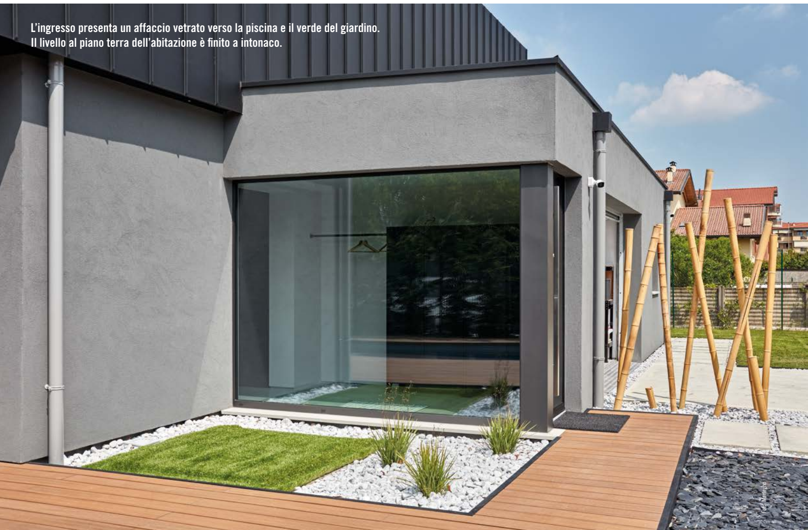
Vista da sud ovest: il volume superiore aggettante è rivestito in lamiera di alluminio preverniciata.
