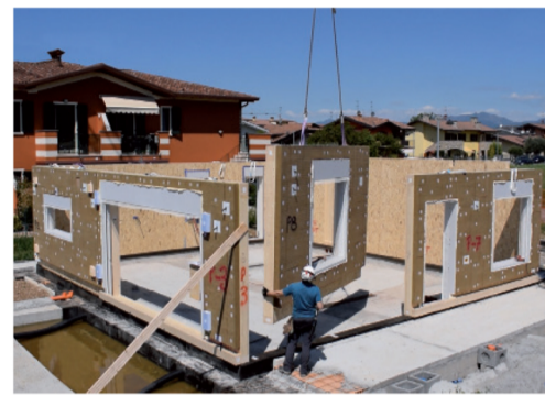
I lavori Un momento della posa in cantiere
