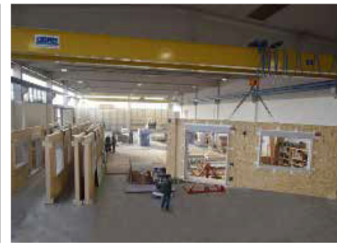
Produzione Parete prefabbricata off-site
