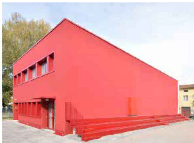
Riqualificazione La palestra di Villaggio Badia rinnovata con sistema AdESA
