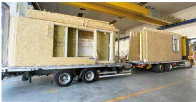
**In partenza** Pareti prefabbricate pronte per l'installazione in cantiere
