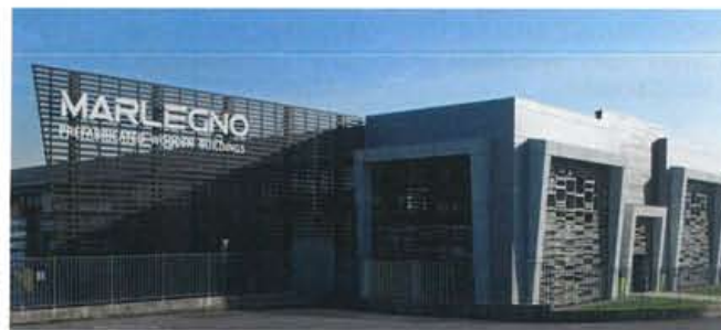
1 - La sede di Marlegno a Bolgare, in provincia di Bergamo.
