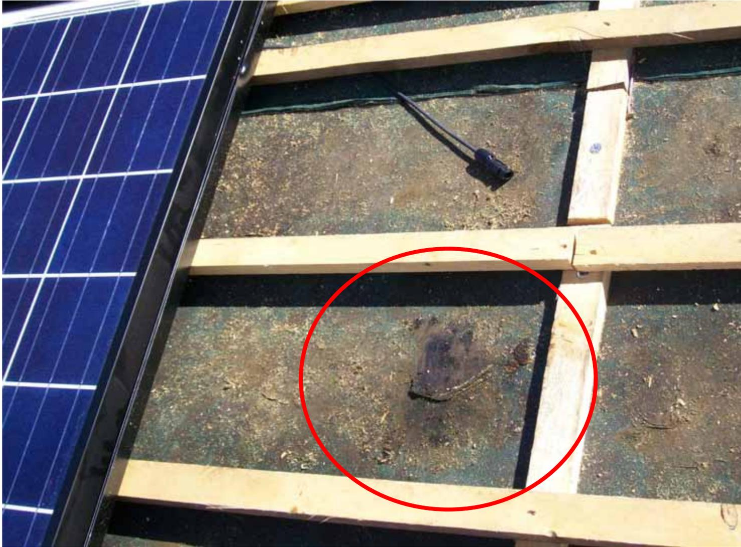
**La membrana conserva le caratteristiche di impermeabilità ?**
