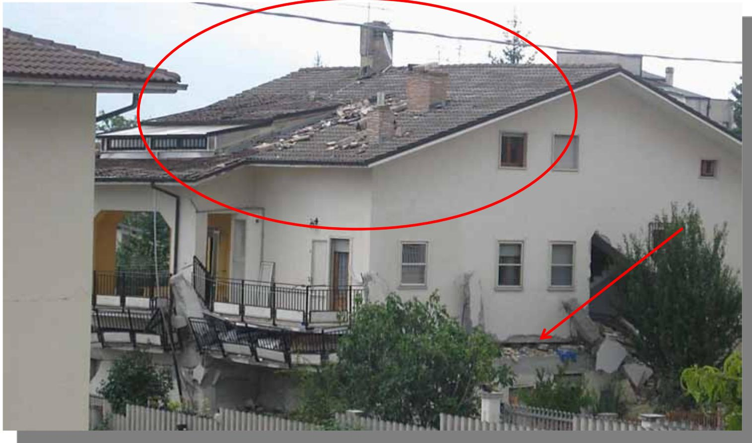
Vista sul retro - edificio con collasso strutturale e manto di copertura in sede, L'Aquila - Italia 2009
