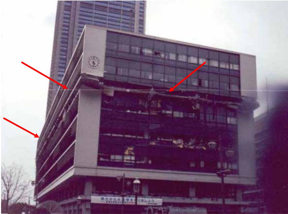
Implosione di un piano dell'edificio - Municipio di Kobe, Giappone - 1995
