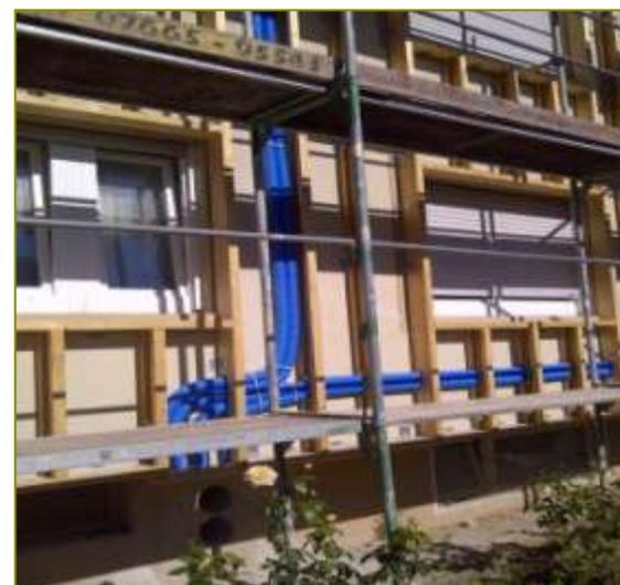
Steico Wall: elementi con base da mm.45/60/90 e altezze da mm.160/500
