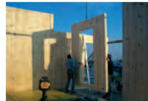
A sinistra, l'edificio esistente in muratura durante la fase iniziale di riqualificazione. A destra, la posa delle pareti in cross-lam prefabbricate.
