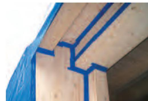
A sinistra, la posa del freno vapore sulla parete inclinata. A destra, un dettaglio della nastratura dei giunti per la tenuta all'aria della struttura.
