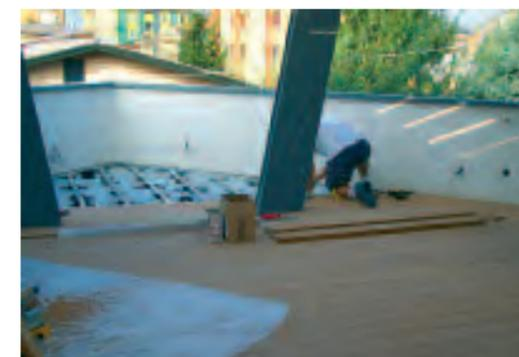
A sinistra, dettaglio dell'attacco della struttura della sopraelevazione in legno (isolata con fibra di legno) alla struttura in muratura preesistente, coibentata con lastre di EPS. A destra, posa del pavimento del terrazzo al secondo piano.
